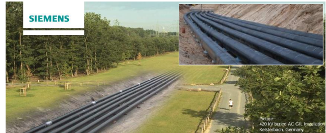
Рисунок 10 – GIL система змінного струму напругою 420 кВ та струмом 3150 А неподалік м. Kelsterbach (Німеччина)
