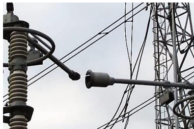
Рисунок 2 – Високовольтний роз'єднувач для зовнішньої установки [4]
