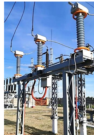
Рисунок 5 – Вимірювальні трансформатори-TOR-110S [8]
