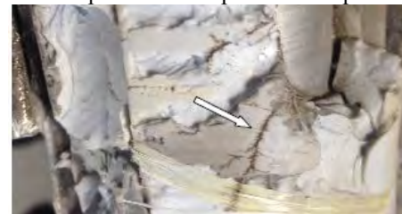
Рис. 1 – Следы электрических разрядов
