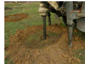
Рис. 1– Скважины под электроды повышенной проводимости растеканию
